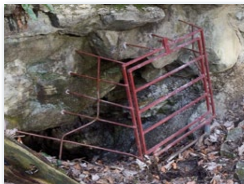
Ein Gittertor schützt die Stollen vor menschlicher Störung. Gleichzeitig bleibt für Fledermäuse, Amphibien und andere Kleintiere der Zugang zum Stollen erhalten.
